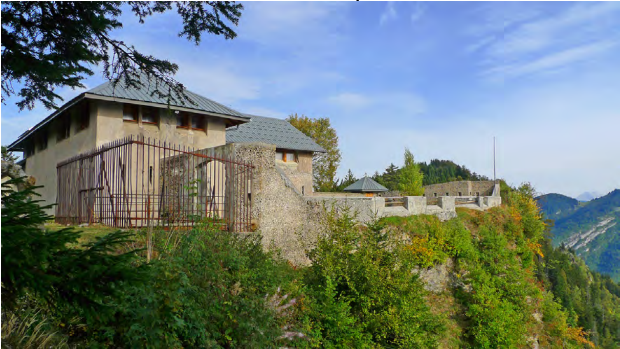
Espace associatif sur 2 niveaux Largeur de l'escalier insuffisant
